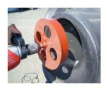
**2-** Placer le bout de la mèche de la scie cloche dans le pré trou de l'opercule. Percer et placer le joint triple lèvre.
