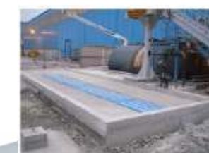
Photo 41. Vue de l'ouvrage achevé
