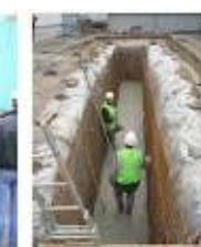
Photo 36. Coulage du radier
