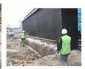
Photo 37. Pose de l'ouvrage préfabriqué
