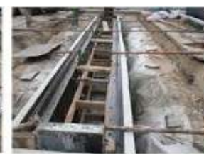
Photo 39. Maintien du coffrage
