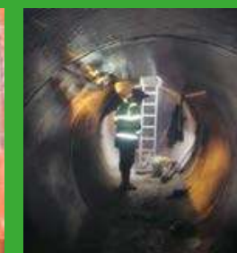
Intérieur de l'aqueduc terminé.
