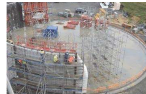
Pose de l'étanchéité sur le coffrage
