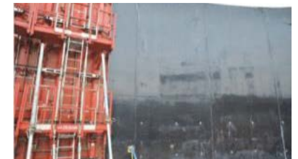
Après le décoffrage
