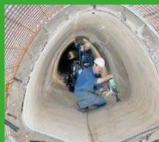
Autre exemple de réhabilitation avec une forme spécifique de conduite.
