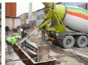
Photo 40. Coulage des voiles
