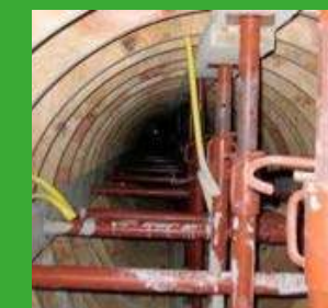
Coffrage de l'Ultra-GRIP® dans l'aqueduc.
