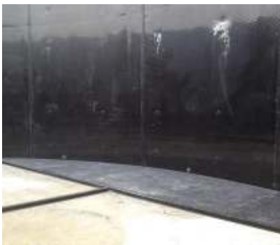
Figure 26. Pose sur profilé PE
