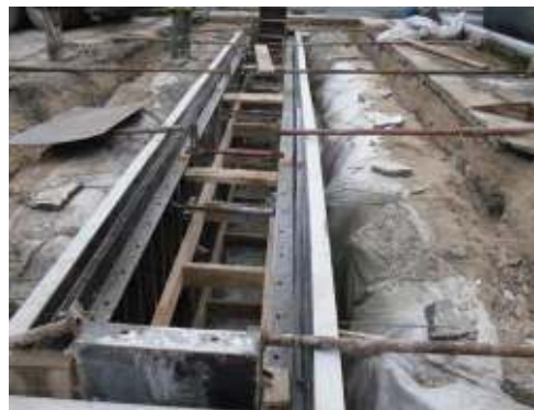
Photo 39. Maintien du coffrage
