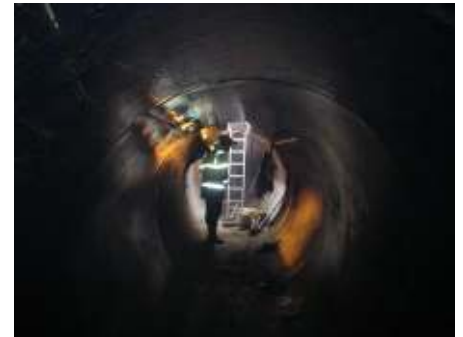
Figure 48. Vue d'un tronçon d'aqueduc
