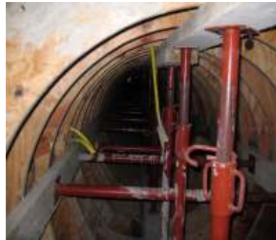
Figure 46. Vue des injecteurs
