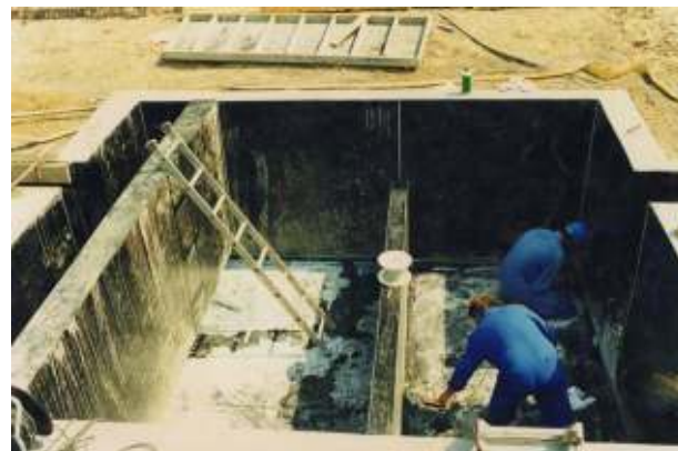
Figure 34. Soudure des voiles
