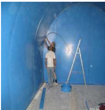
Figure 6. Etanchéité en voute
