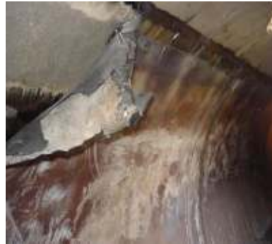
Figure 43. Etanchéité en plomb
