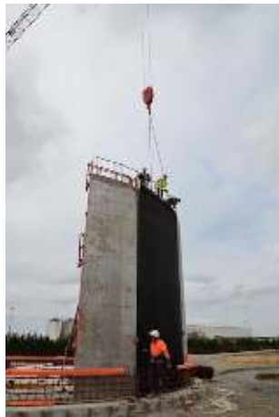
Figures 24 et 25. Pose du panneau SURE GRIP sur le coffrage
