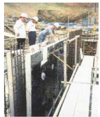
Figure 56. Pose du voile
