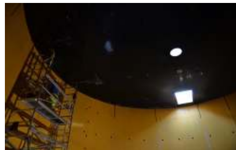
Figure 29. Vue en sous face d'un digesteur
