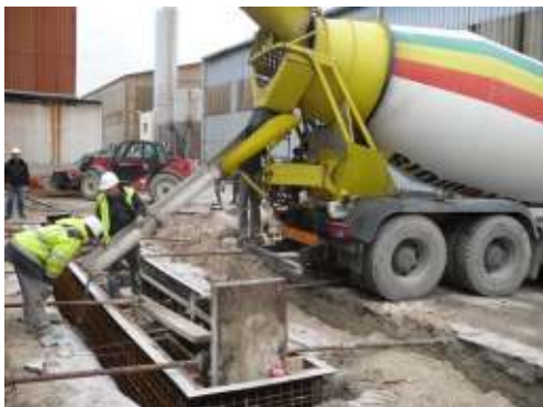
Photo 40. Coulage des voiles
