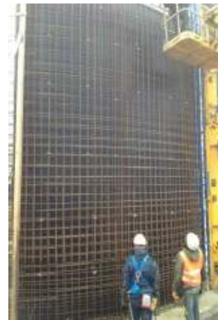
Figures 24 et 25. Pose du panneau SURE GRIP sur le coffrage
