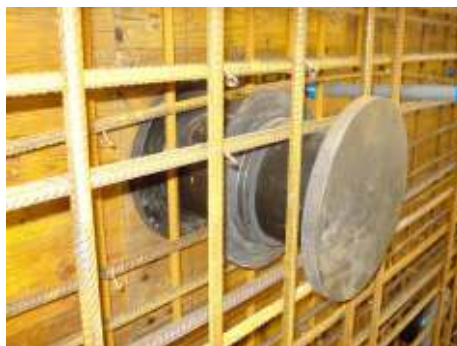
Figure 31. Traversée de paroi
