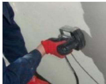
Figure 13. Soudure par induction
