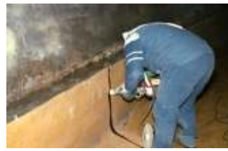
Figure 53. Soudure par extrusion
