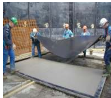
Figure 27. Pose de SURE GRIP sur un béton frais
