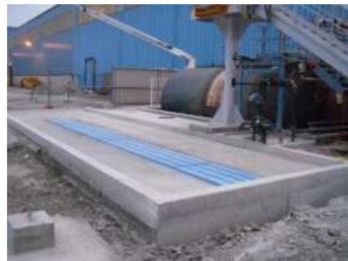
Photo 41. Vue de l'ouvrage achevé
