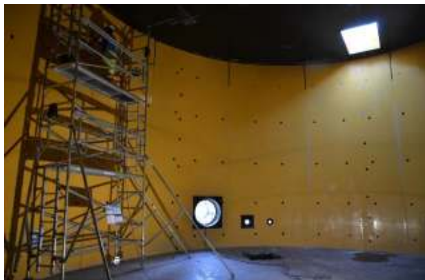
Figure 33. Soudure en plafond
