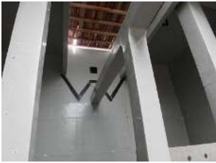
Figure 16. Habillage de poutres
